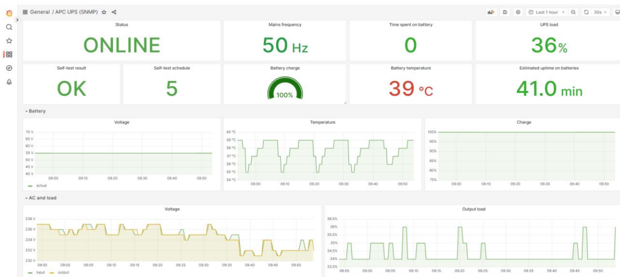
Рисунок 2.8 – Данные работы бесперебойного блока питания
