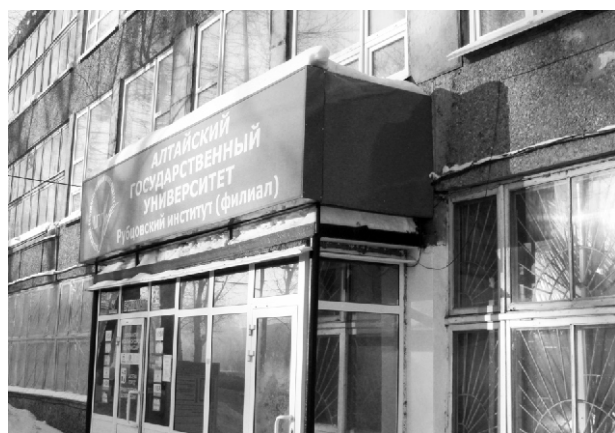
Здание Рубцовского института, 1 корпус
