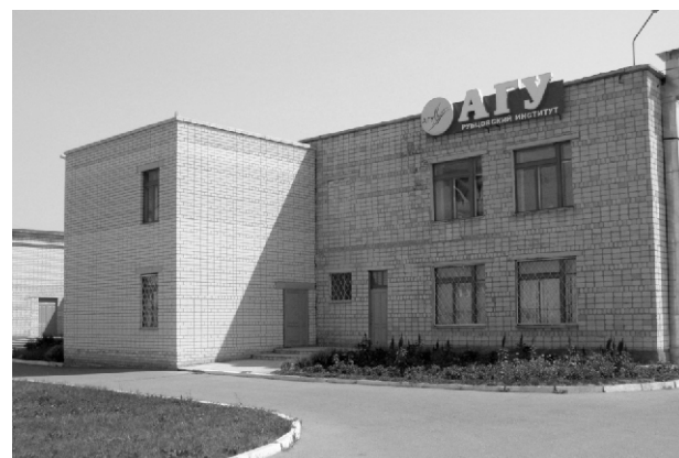
Здание Рубцовского института, 2 корпус
